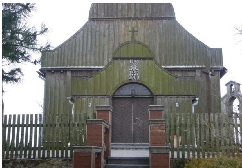
Kościół parafialny pw. św. Stanisława, drewniany, 1790, nr rej.: 813 z 28.12.1967 oraz 17/A z 31.08.1994 ( źródło: z zasobów własnych)
